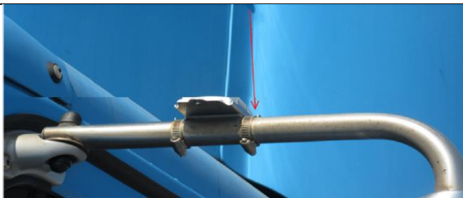
Instalación de un clamp pequeño
