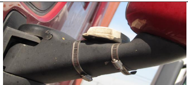
Instalación de un clamp grande
