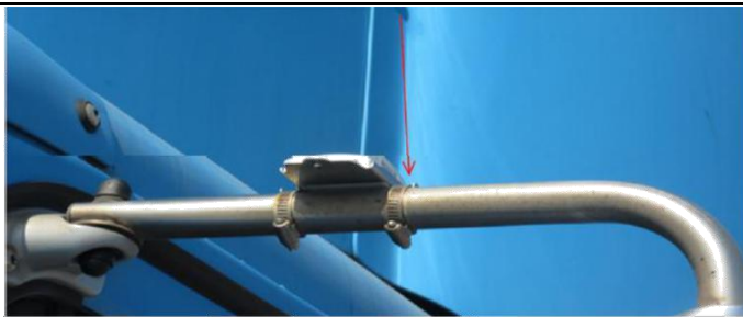
Instalación de un clamp pequeño
