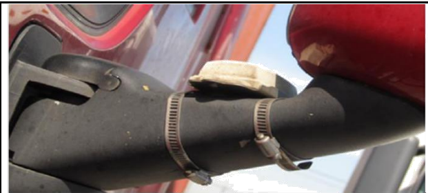
Instalación de un clamp grande
